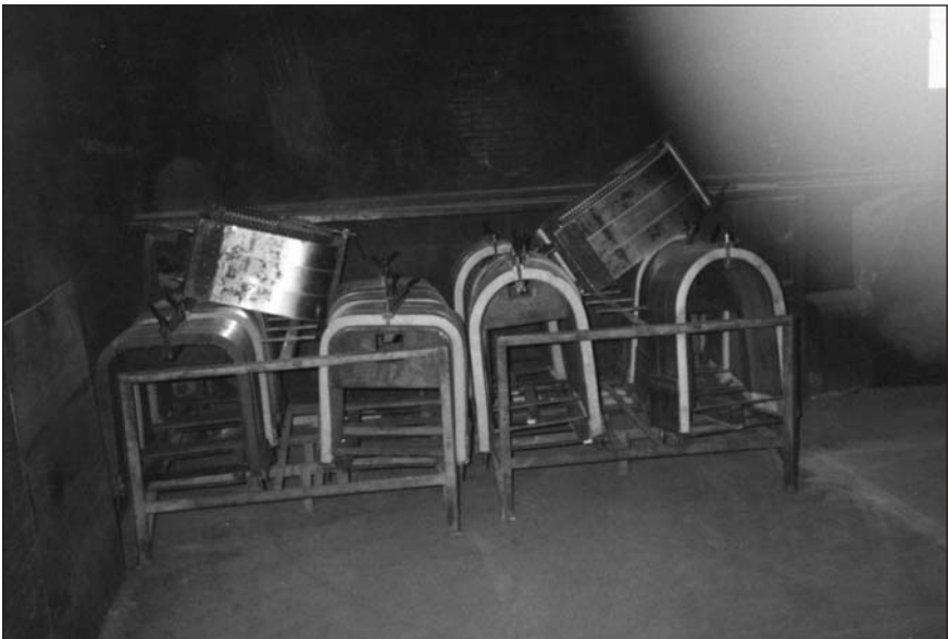
Els motles del moble corbat romanien a l'interior de l'eixugador durant tota la nit.
