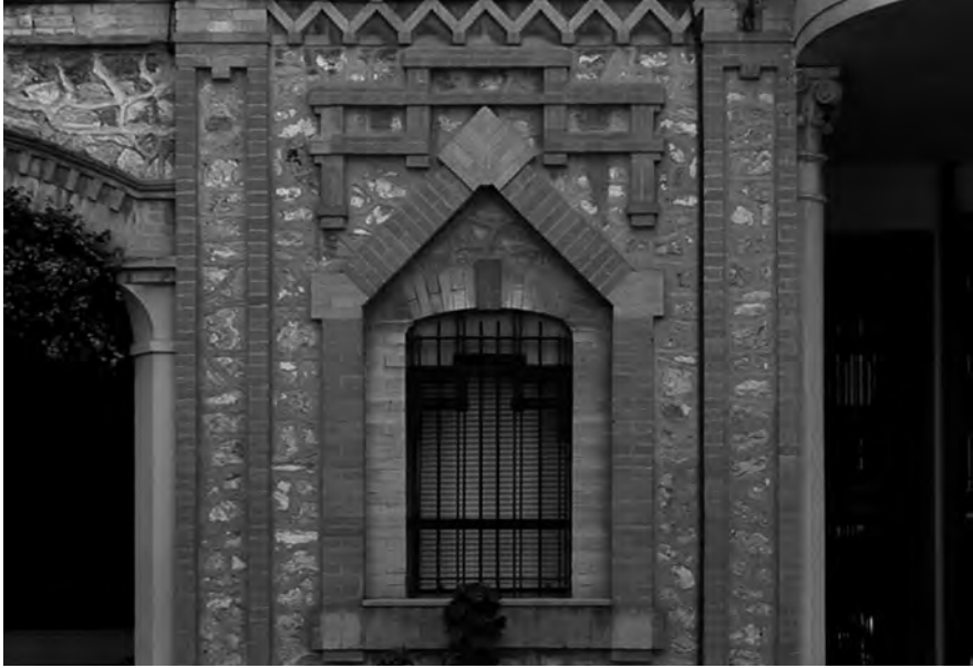
Imatge 7. Finestra de la façana principal de La Puríssima, en la que es barregen diferents aparells de rajola. (Jesús del Ramo, 2010)
