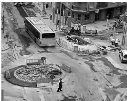
Policía Local regulando el tráfico en las obras de la avd. Blasco Ibáñez, 2006.
