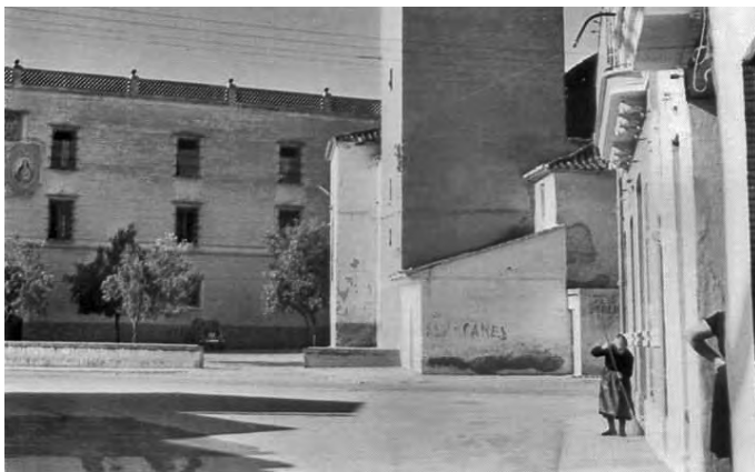
A l'esquerra, aspecte que presentava una part de la façana principal del convent de les Oblates durant la postguerra. La imatge fou presa des del carrer del Convent.
