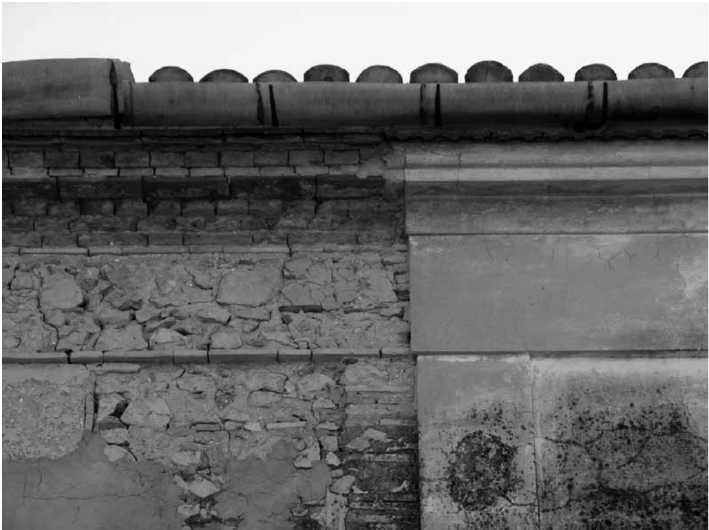
Casa d'hort a Alzira (UTM 732245-4335600). La meitat de la façana que va quedar sense acabar mostra els materials emprats en la construcció, mentre que l'altre costat que va quedar rematat mostra el seu aspecte motllurat final.
