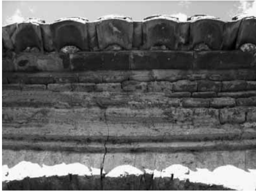
Aspecte original del ràfec abans de ser lluït.
