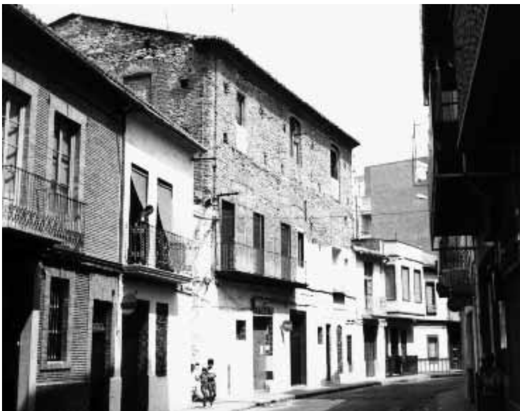
Aspecte de l'edifici amb el seu entorn abans de la restauració.
