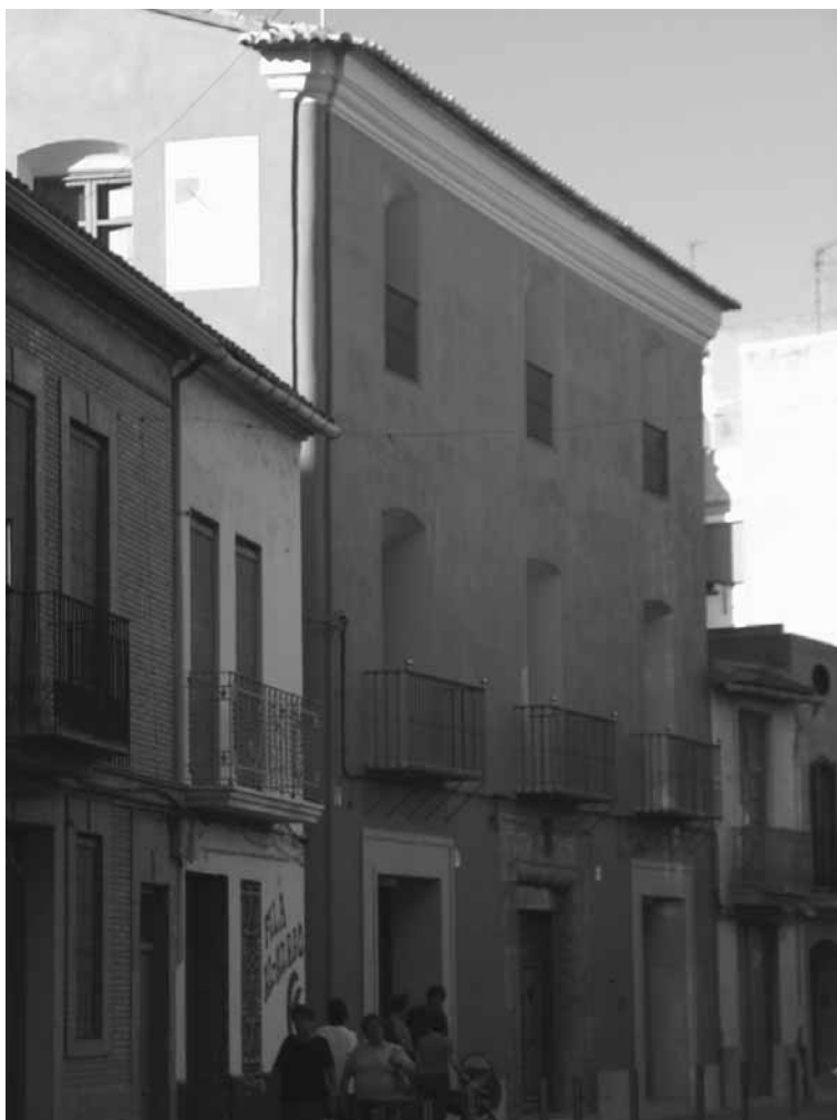
Vista de la façana ja restaurada.
