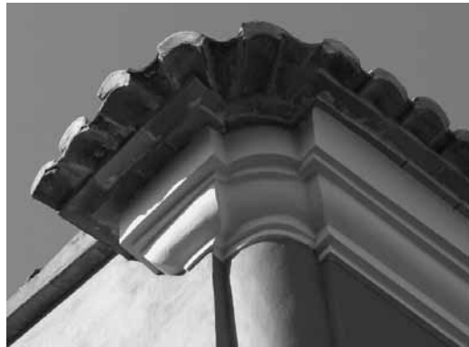
Aspecte del ràfec després del seu lluït i de ser reparada la coberta.
