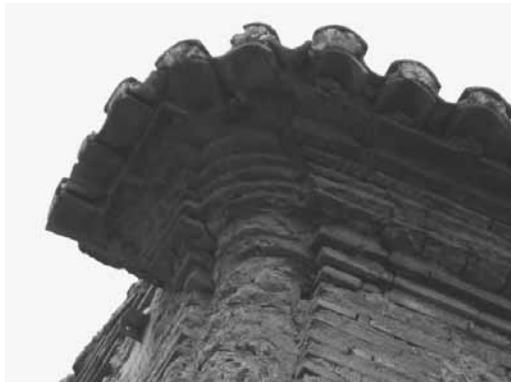
Aspecte original del ràfec abans de ser lluït.
