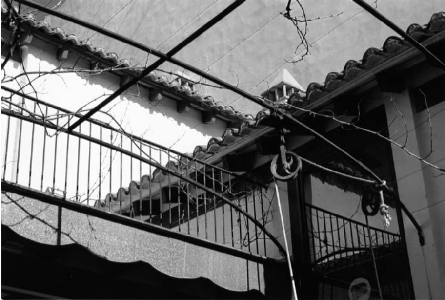
Detall de la corriola que servia per a enganxar i apujar a la pallissa els aixavegons de palla.
